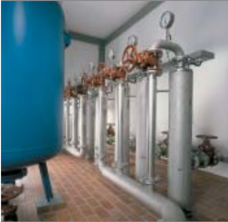
Вертикальный монтаж бустерных насосов на станции водоснабжения в г. Имменрайт (Германия)
