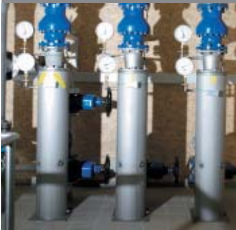
Вертикальный монтаж бустерных насосов на заводе Венценбах (Германия)
